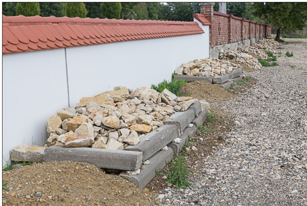
Abb. 9: Friedhofmauer Süd – Istzustand am 17.9.2022
