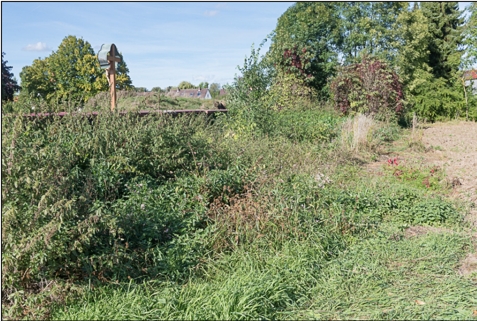
Abb. 10: Friedhofmauer Ost – Ausgangszustand am 30.9.2021
