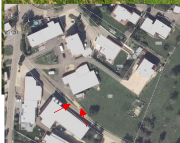
Abbildung 17: Ansicht auf die geschotterte Zufahrt zur Garage von Süden und Süd-Ostern her.
